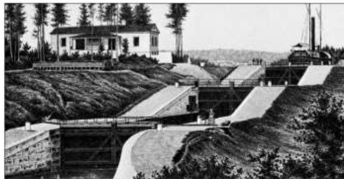
En ångbåt på väg upp genom slustrappan vid Iso-Pelli i gamla Saima kanal 1867. Pelli ligger numera på den rysha sidan av kanalen. Kanalen byggdes om helt efter att ha varit stängd efter kriget och återöppnades 1968 med större men färre slussar. Foto från boken Viipuri - kaupunki kanavien päässä (1977)
