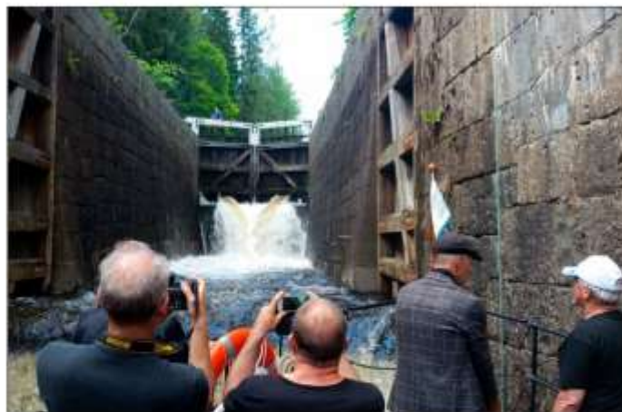
Uppbussning i den nedre dubbelslussen i Semla 15 juli. Portarna mellan slussarna är helt öppna och vattnet strömmar fritt från luckorna i översta portparet. RUNN ligger diagonalt i slussen för att fiskeppet inte skall pressas ut av strömmen.
